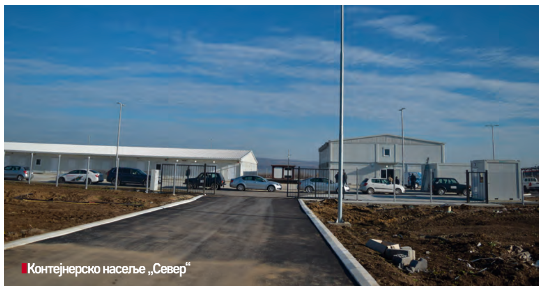
Значајни ремонти на ПК „Дрмно“
